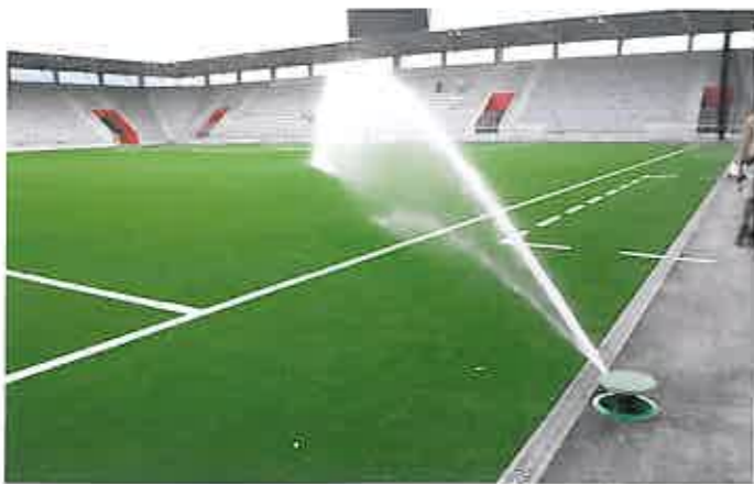
Demonstration «Rasensprenger» mit vorhandenem Druck von nur 5 bar
